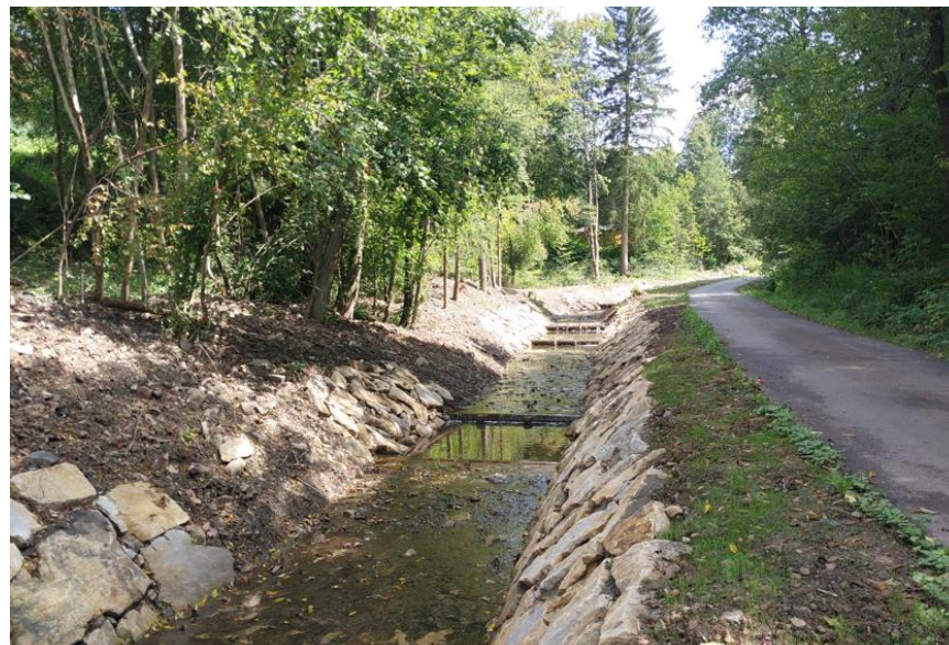
Lýkový p. v Jablůnce – stabilizace údolní silnice
