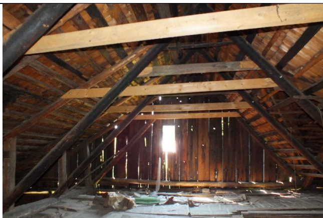
Torzo krovové konstrukce původní stavby – tmavě zbarvené konstrukční prvky.
