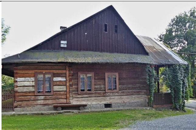
Okapní stříška na severní straně objektu.
