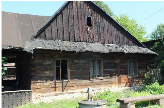
Okapní stříška na severní straně objektu.
