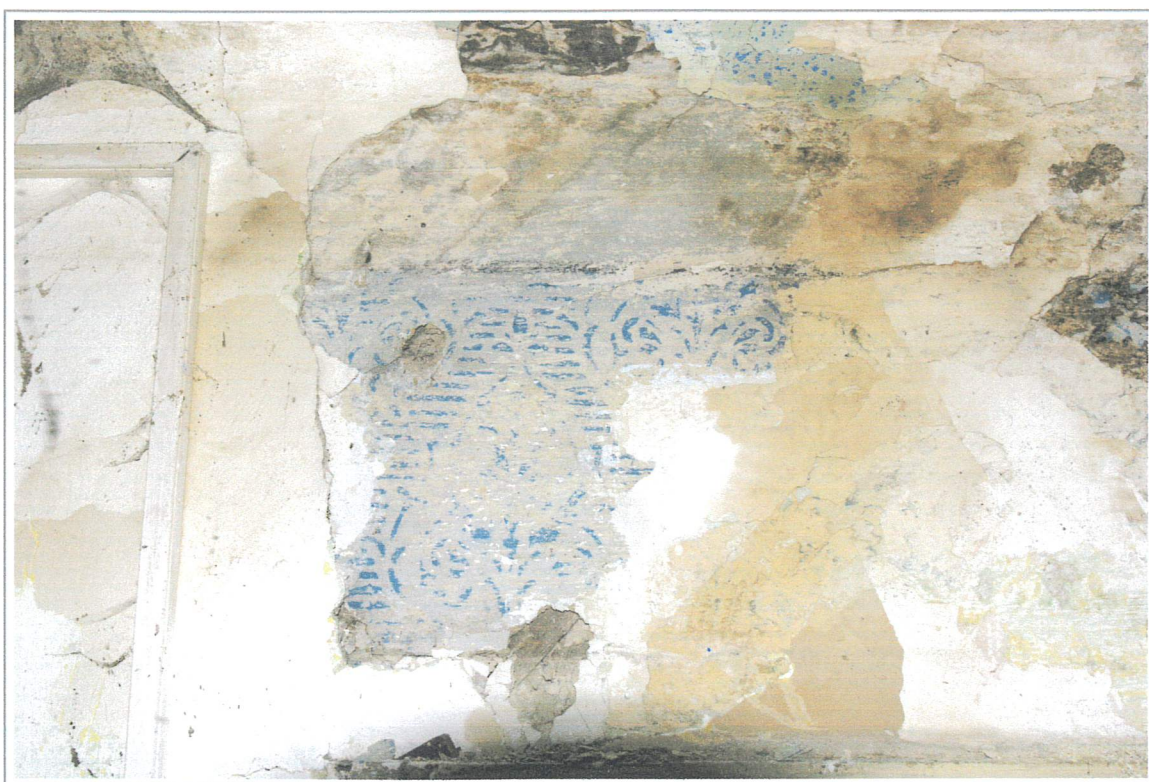
Obr. č. 36.: Pohled na stěnu místnosti za světnicí. Na stěně došlo k samoodryvu nejstarší dochované vrstvy v podobě modré šablonové malby na šedém pozadí. V horní části je viditelná část mladší vrstvy výmalby charakterizované modrým stříkaným dekorem na chladném zeleném pozadí. Na stěnách jsou četné zatekliny a dehtové skvrny.
