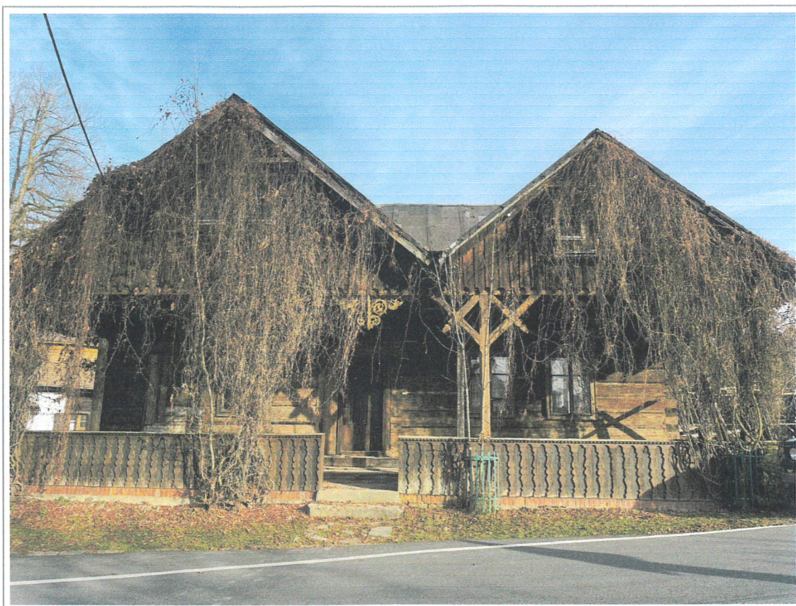
Obr. č.24.: Pohled na čelní stranu budovy s hlavním vstupem orientovanou na východ.
