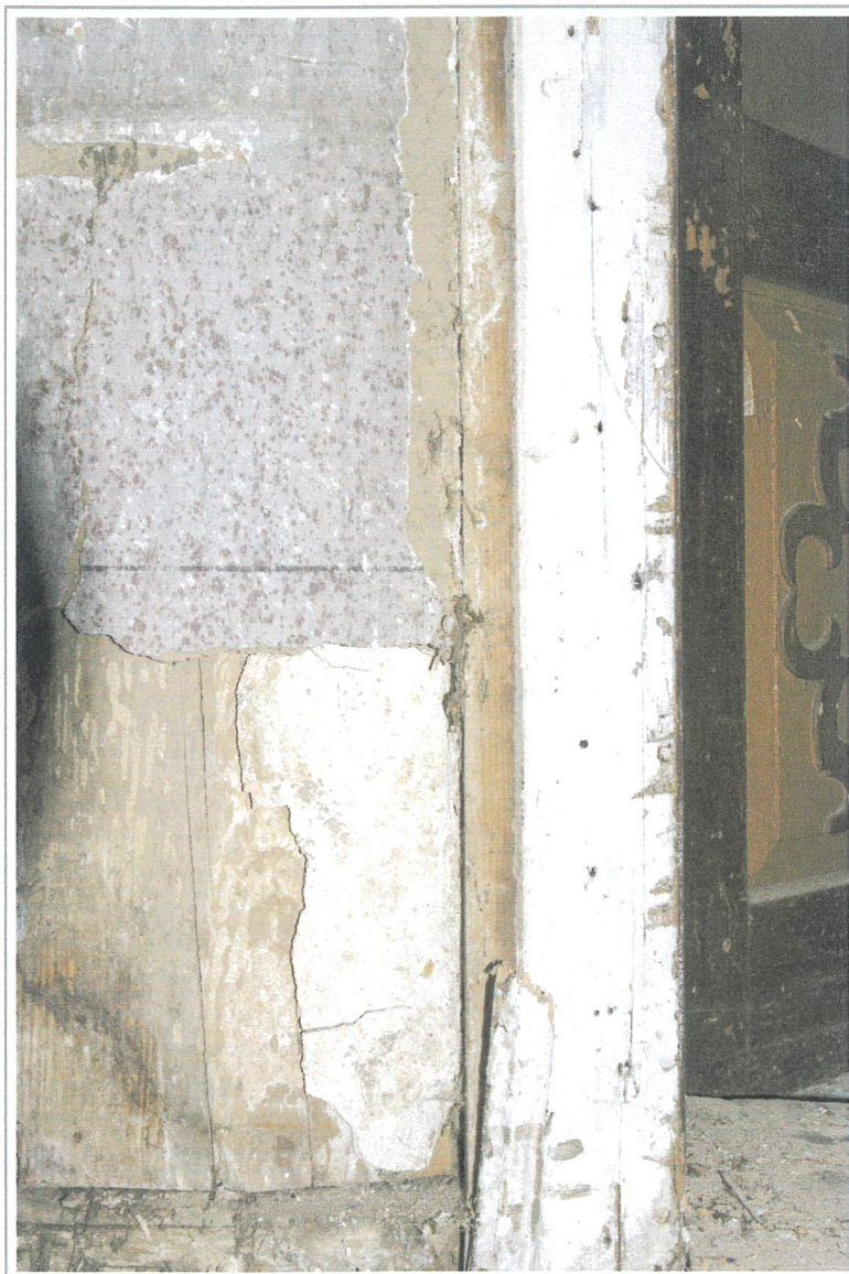
Obr. č. 32.: Pohled na jižní stěnu chodby. Pod omítkou nesoucí na svém povrchu dekorativní stříkanou malbu se nachází starší vrstva. Jedná se o vápennou omazávku a souvrství bílých vápenných nátěrů přímo na dřevě. Patrně se jedná celkově o nejstarší nalezenou povrchovou úpravu stěn v objektu.
