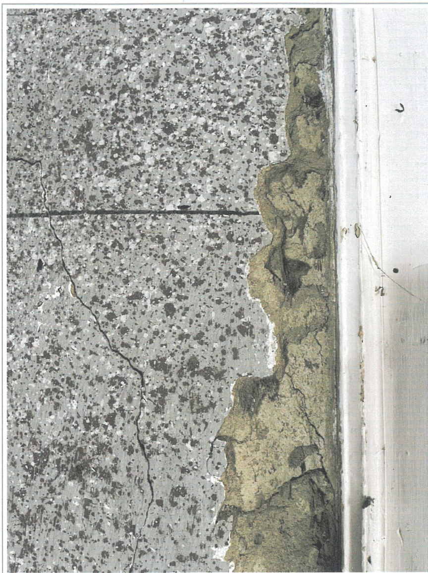
Obr. č. 33.: Pohled na jižní stěnu chodby, detail stříkané dekorativní malby.
