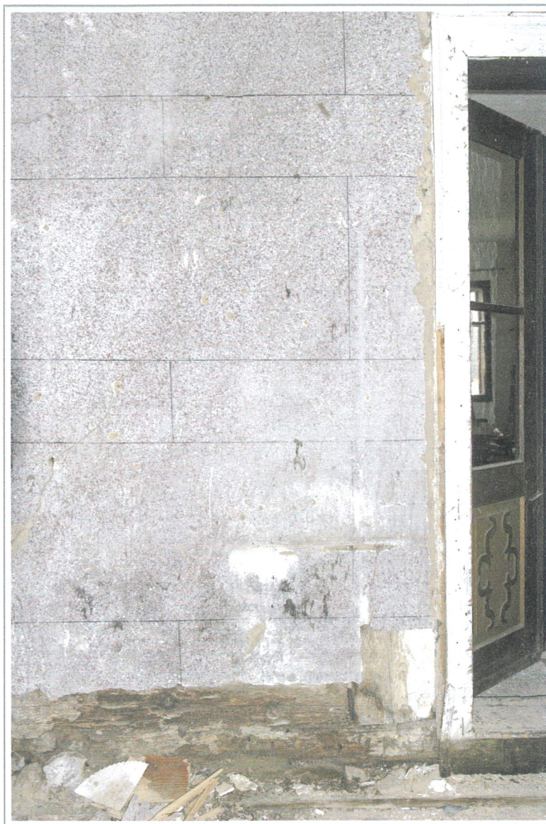
Obr. č. 31.: Pohled na jižní stěnu chodby. Na snímku je dobře viditelná vrstva se stříkanou malbou a linkovaným kvádrováním.
