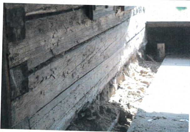
FOTO 08: Detaily stavu roubení na západní straně objektu. Patrné je druhotné použití prvků a materiálová různorodost. Poškození je zejména ve spodní prahové partii a v horních partiích. Středová část je poškozena lokálně. Vrchní partie je degradována díky zatékání do stropní konstrukce skrze havarijní střešní plášť. Poškození je způsobené dřevokaznými houbami z oddělení Basidiomycota. Z dřevokazného hmyzu byla diagnostikována zejména činnost tesaříka krovového ( Hylotrupes bajulus L.).
