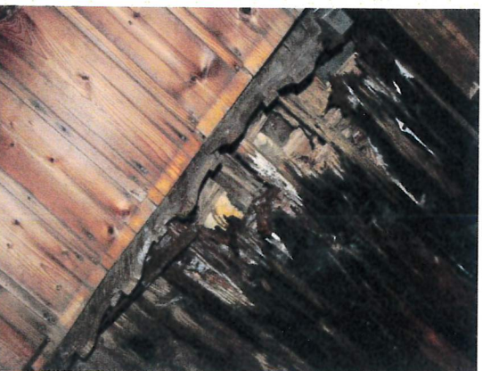
FOTO 03: Stav stropní konstrukce nad místnostmi č. 104 a č. 105. Dole detail podepření stropní konstrukce verandy na západní straně objektu. Stropní konstrukce nad místnostmi č. 104 a č.
