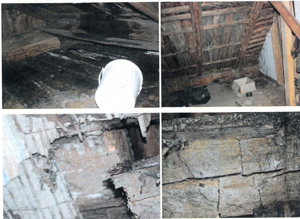
FOTO 02: Stav stropní konstrukce nad místností č. 103. Patrný je havarijní stav celé stropní konstrukce. Z prostoru půdy byly diagnostikovány dřevokazné houby, zejména popraška sklepní ( Coniophora puteana ) a pórnatka velkopórá ( Donkioporia expansa ). Na několika místech byly diagnostikovány mikroskopické nedokonalé houby tzv. plísňe ( Deuteromycotina ).
