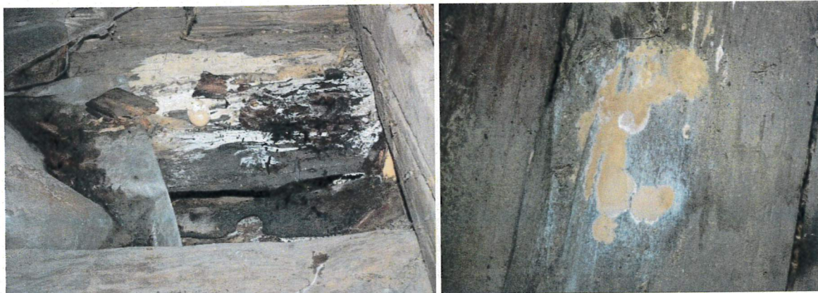
FOTO 02: Stav stropní konstrukce nad místností č. 103. Patrný je havarijní stav celé stropní konstrukce. Z prostoru půdy byly diagnostikovány dřevokazné houby, zejména popraška sklepní ( Coniophora puteana ) a pórnatka velkopórá ( Donkioporia expansa ). Na několika místech byly diagnostikovány mikroskopické nedokonalé houby tzv. plísňe ( Deuteromycotina ).
