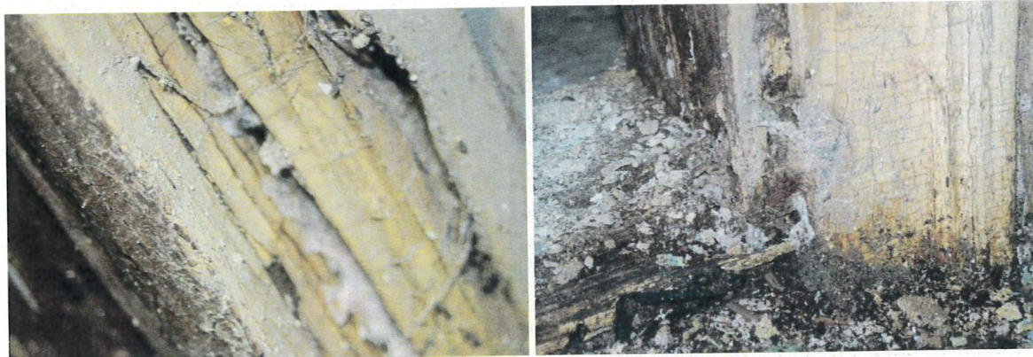
FOTO 09: Pohled na rozsah činnosti dřevokazné houby dřevomorky domácí ( Serpula lacrymans L.). Kolonizace je patrná v zárubních dveří, přilehlé podlaze v chodbě a podlaze v obou rozích a stěnách místnosti č. 103.
