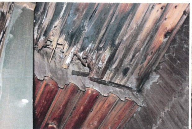
FOTO 03: Stav stropní konstrukce nad místnostmi č. 104 a č. 105. Dole detail podepření stropní konstrukce verandy na západní straně objektu. Stropní konstrukce nad místnostmi č. 104 a č.
