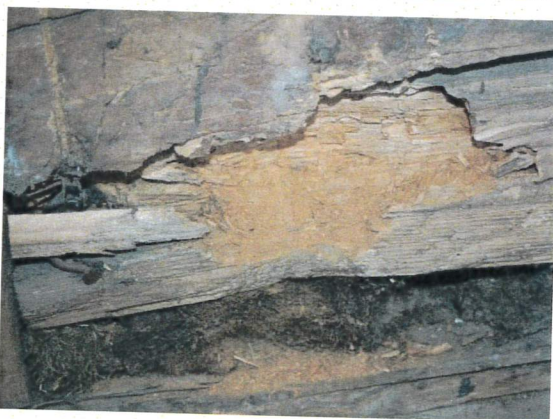
FOTO 08: Detaily stavu roubení na západní straně objektu. Patrné je druhotné použití prvků a materiálová různorodost. Poškození je zejména ve spodní prahové partii a v horních partiích. Středová část je poškozena lokálně. Vrchní partie je degradována díky zatékání do stropní konstrukce skrze havarijní střešní plášť. Poškození je způsobené dřevokaznými houbami z oddělení Basidiomycota. Z dřevokazného hmyzu byla diagnostikována zejména činnost tesaříka krovového ( Hylotrupes bajulus L.).
