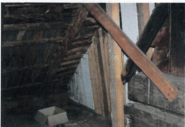
FOTO 06: Detaily stavu roubených prvků ostatních vybraných stěn. Patrné lokální defekty způsobené dřevokaznými houbami a hmyzem. Také je patrné poškození ohněm.
