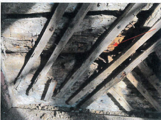
FOTO 06: Detaily stavu roubených prvků ostatních vybraných stěn. Patrné lokální defekty způsobené dřevokaznými houbami a hmyzem. Také je patrné poškození ohněm.
