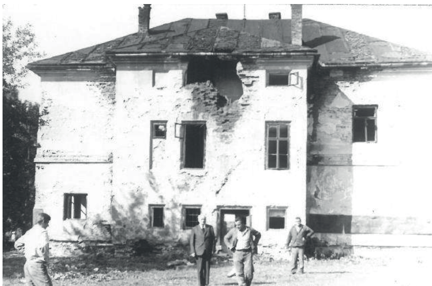
Zchátralá budova bývalé Národní školy před demolicí
