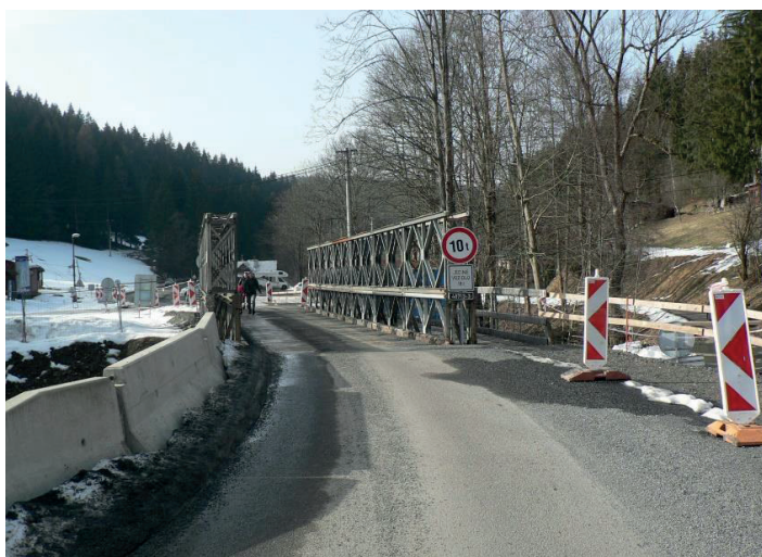
Pluskovce - oprava mostu
