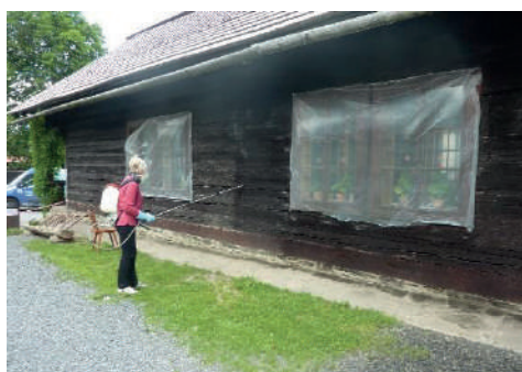
Chemické ošetření budovy IC
