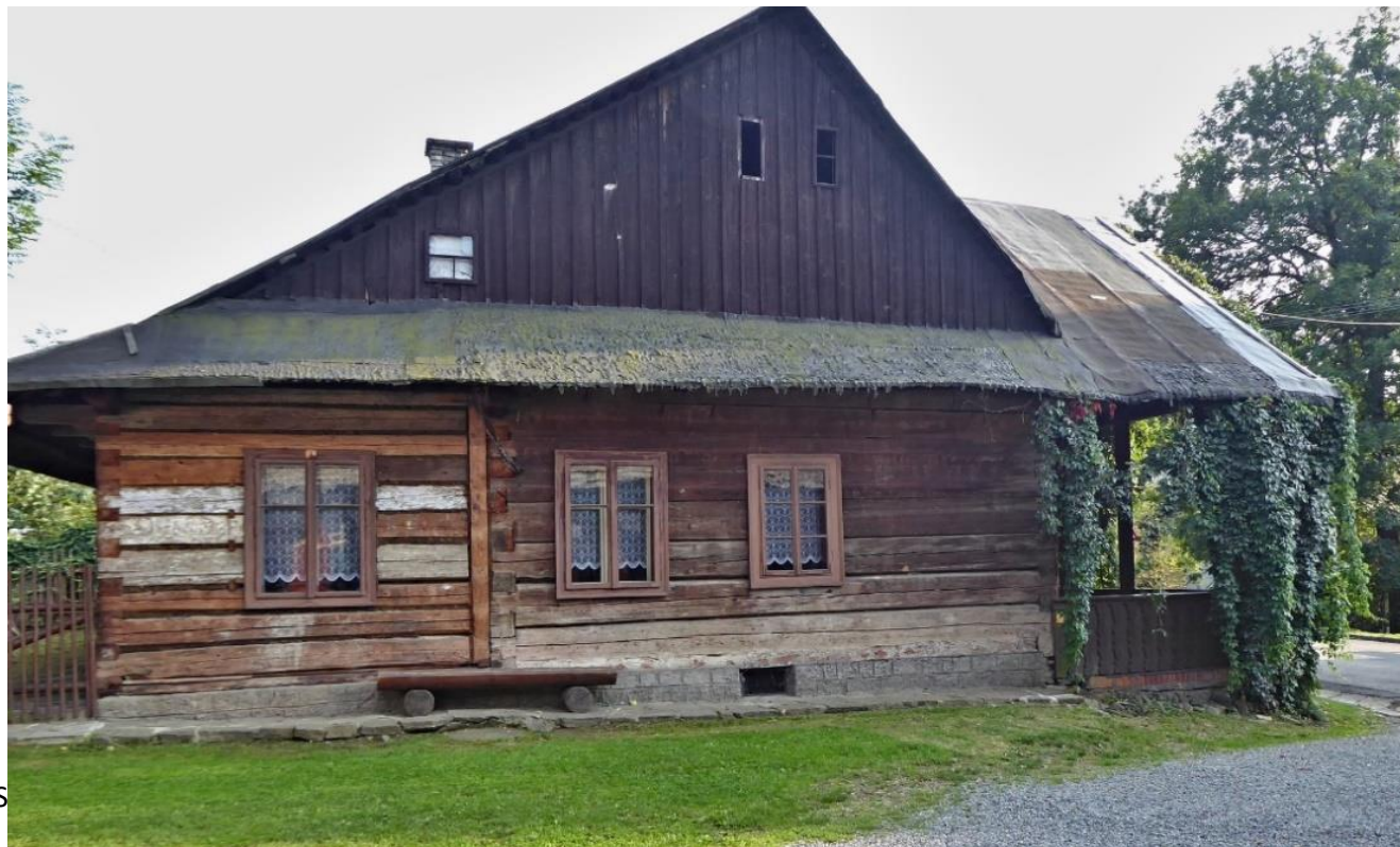
3. Severní strana chalupy bez poškození, s trámy dobrých mechanických vlastností.
