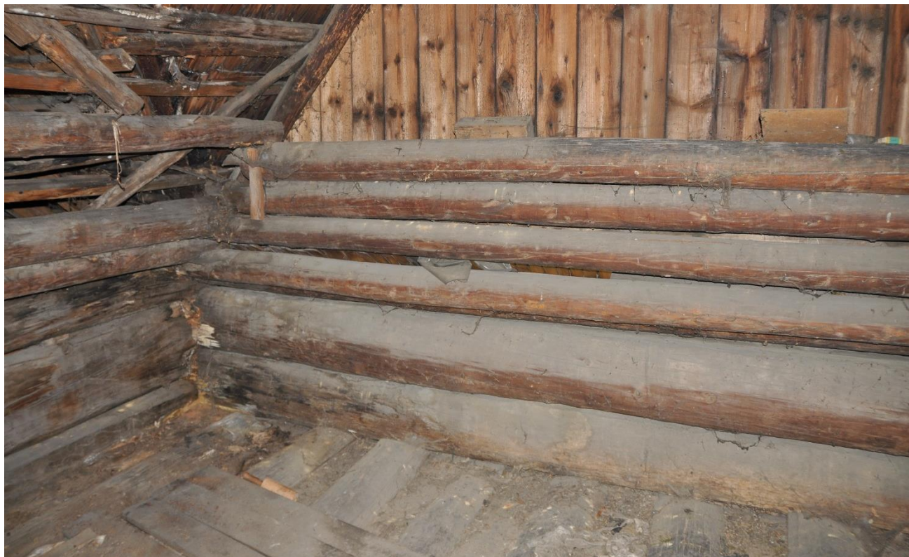
SEVERNÍ STĚNA PODKROVNÍ KOMORY
