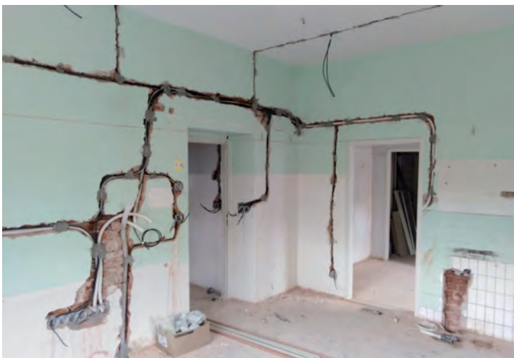
Stavební úpravy v ordinaci zubního lékaře
