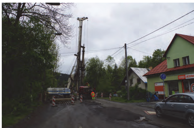
Rekonstrukce mostu v Léskovém
